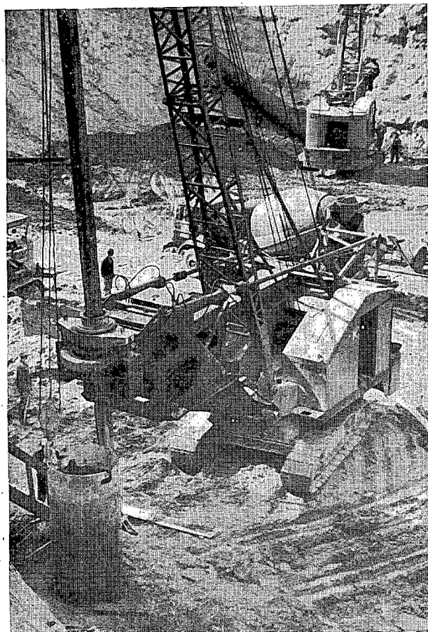
Foto 3. — Introducción del tubo para cortar las filtraciones.
