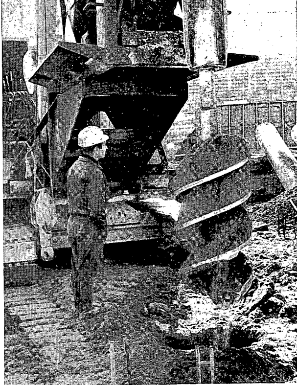
Foto 2. — Comienza la perforación. Las tierras son extraídas con la propia hélice.
