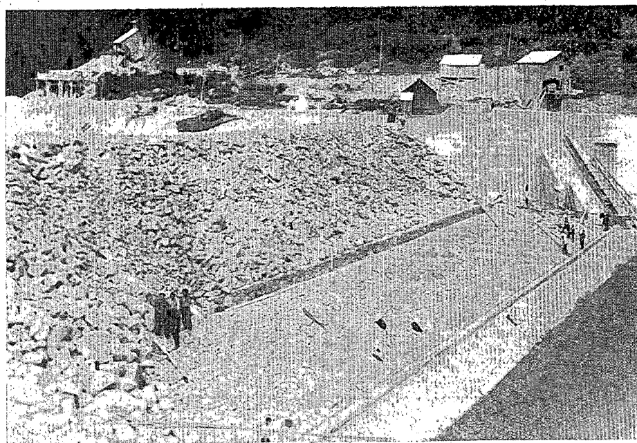
Foto 4. — Colocación a mano de la escollera superficial en un metro de espesor en segunda etapa. Puede observarse que el embalse inunda ya, parcialmente, la parte de pantalla realizada en primera etapa. A la derecha se observa cómo remonta el muro rastrillo hasta insertarse con el canal aliviadero, construido sobre roca.
