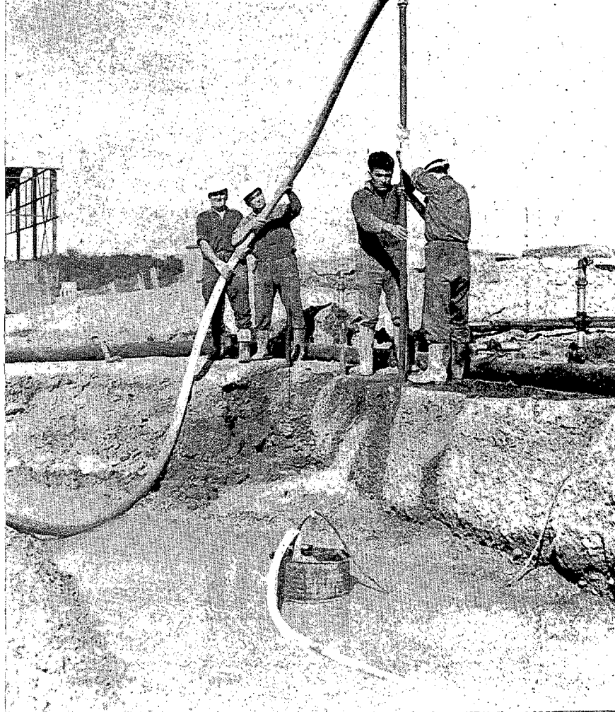
Fig. 5. a . — Hincas de wellpoint por inyección.
