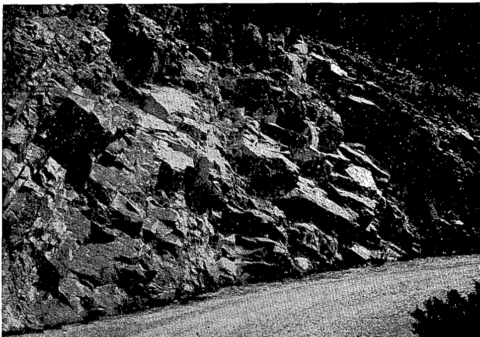
Foto 3. — Aspecto prismático de un frente de excavación del granito de Boadella producido por los sistemas de diaclasado que lo afectan.
