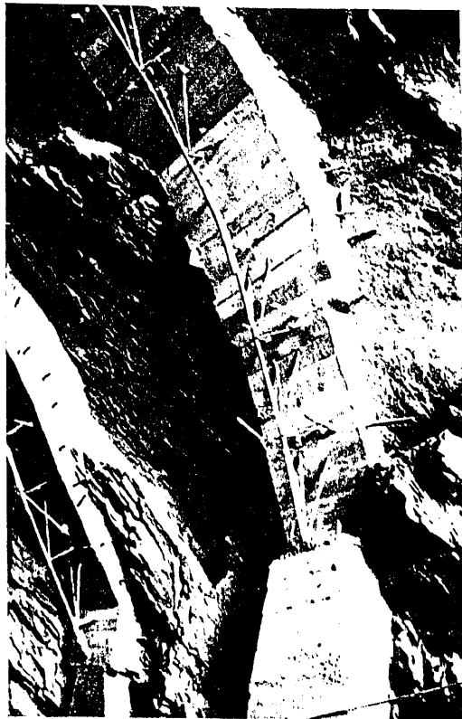
Foto 7.ª — Arcos auxiliares hormigonados y desencofrados.
