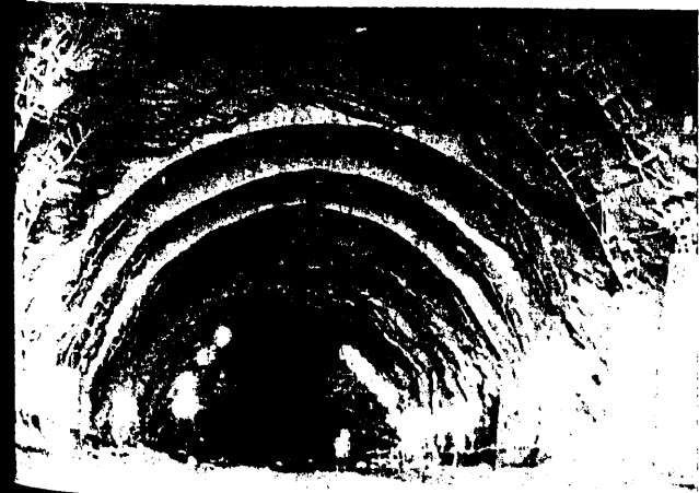
Foto 2.ª — Arcos para reforzar la parte superior del túnel.
