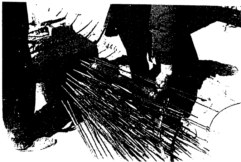
Fig. 14. -- Tensando los alambres. Cada alambre recibe una tensión de 4.450 Kg., equivalentes a la unitaria de 11.500 Kg./cm. 2 .
