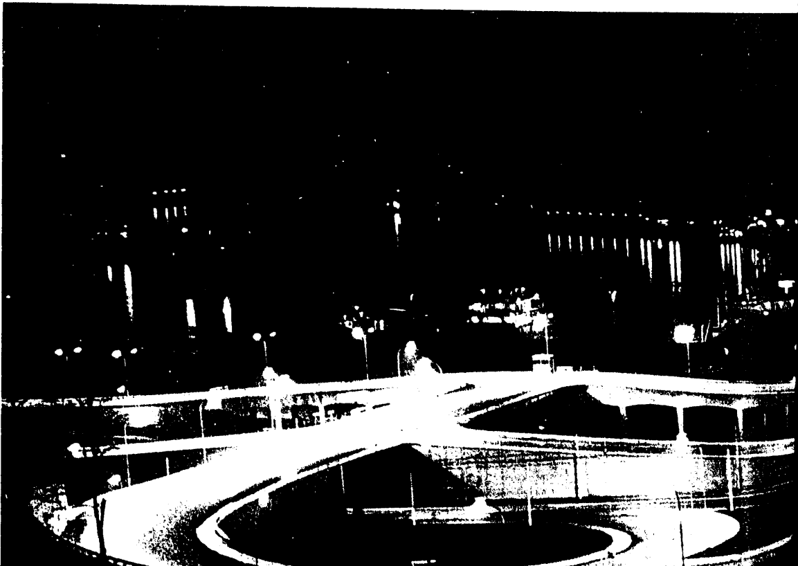
Fig. 5.ª — La misma vista anterior, pero con la iluminación
