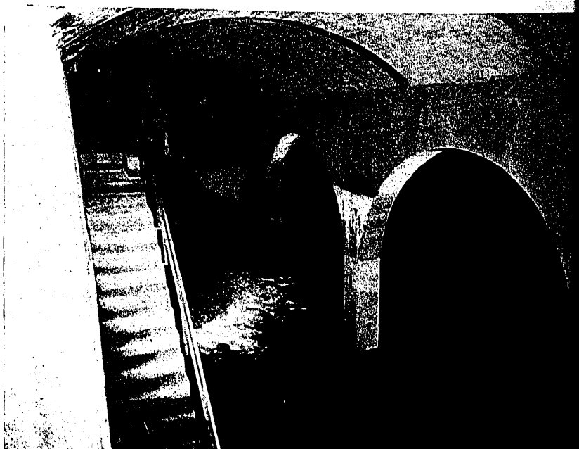
Depósitos.—Vista interior y entrada de agua.
