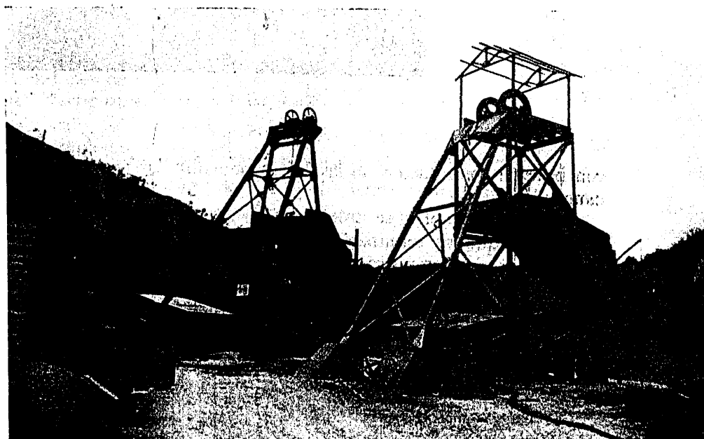
Fig. 35.—Instalaciones de extracción para la ejecución de pozos.
