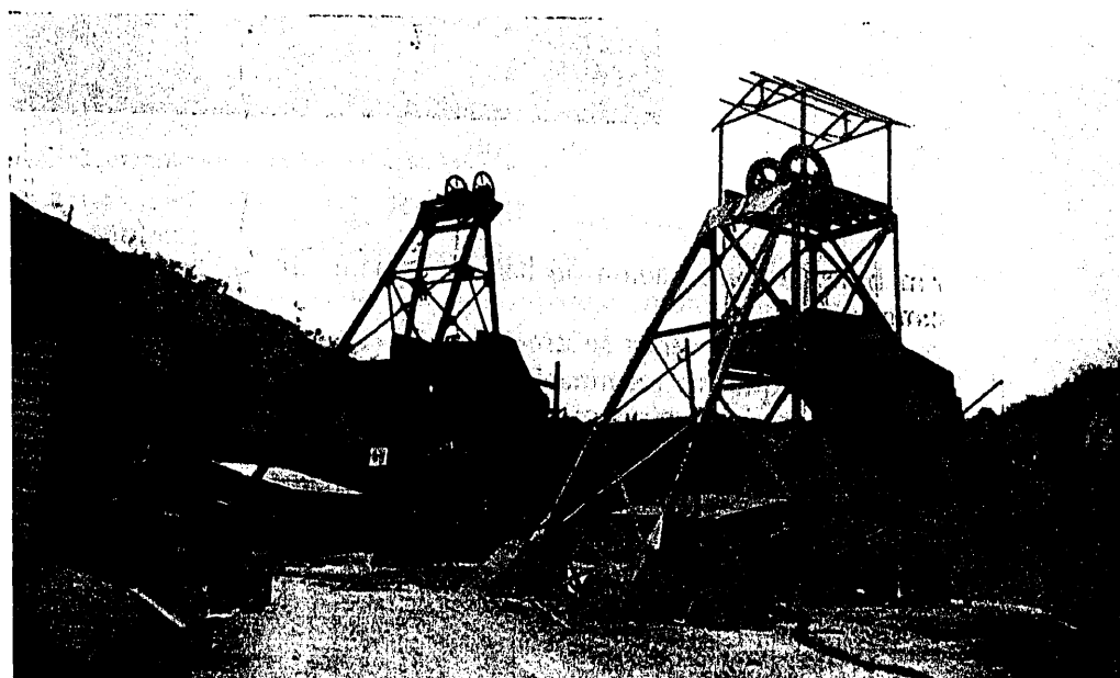
Fig. 35.—Instalaciones de extracción para la ejecución de pozos.
