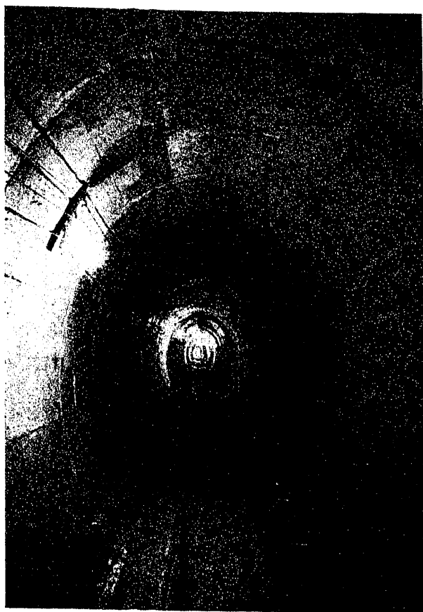
Fig. 12.— Túnel con sección en herradura.
