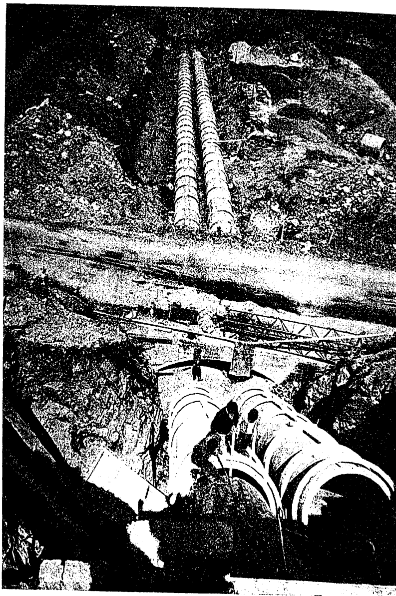
Fig. 13. — Tuberías del sifón de Osor.
