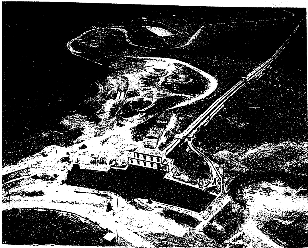
Fotografía núm. 15. — Depósito superior del Salto de Torrelaguna.
