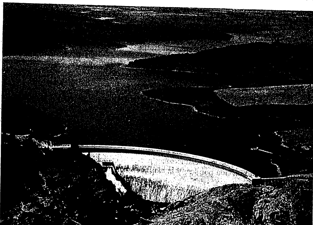
Fotografía núm. 2. — Embalse de Puentes Viejas (río Lozoya).
