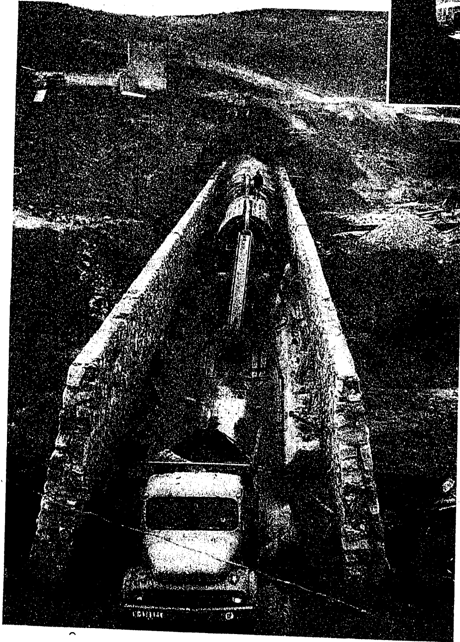
Fotografía número 12.-- Canal de El Atazar. Sección de canal. Disposición sobre acueducto en construcción.
