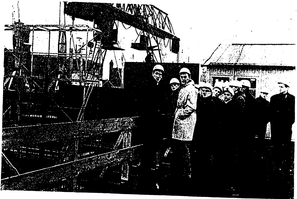
Fig. 7. a — Grupo de participantes visitando las obras de superficie del Y-Tunnel de Amsterdam.
