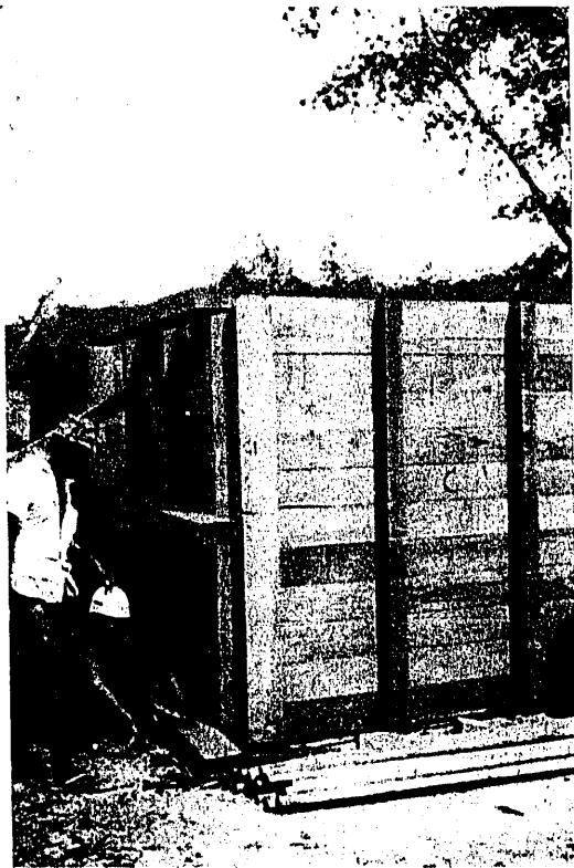
Fig. 3. a —Montaje del encofrado de los bloques tipo C, correspondiente a las hiladas superiores de los muelles a —4,50 y —2,50.
