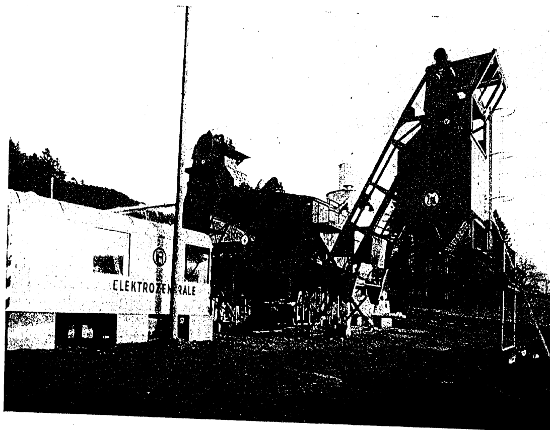
Planta asfáltica OHL-100-120 Tn/h. en la República Federal Alemana.
