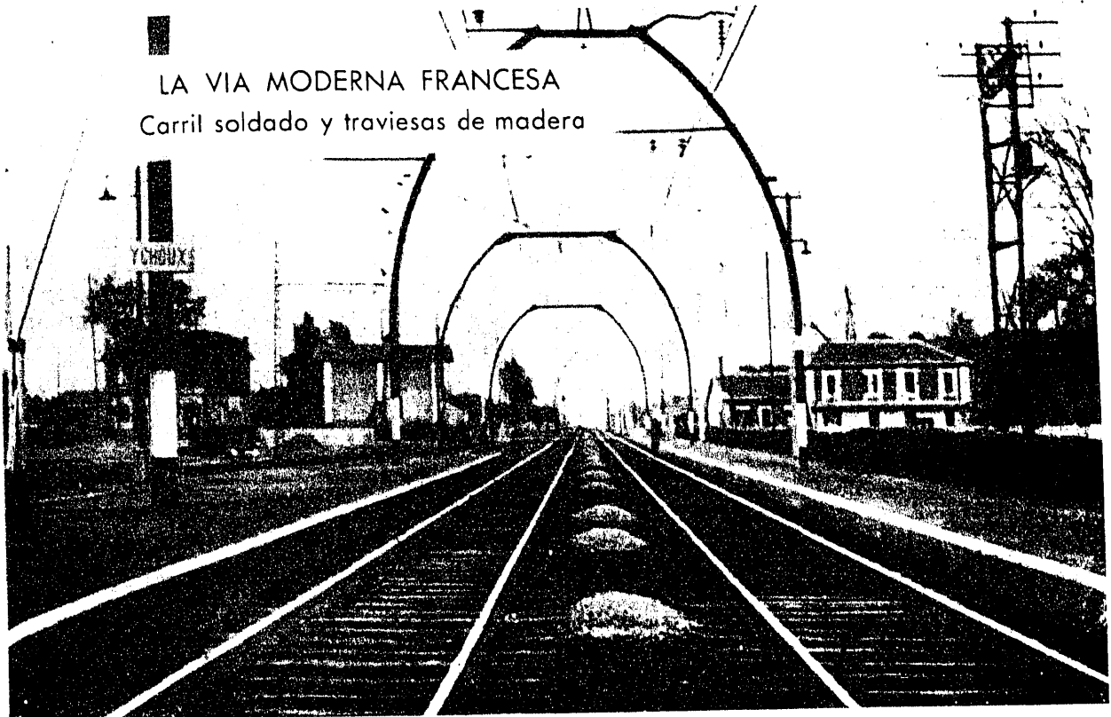
Fig. 6. a — Sobre esta vía de carril soldado y traviesas de madera en el trayecto Trém-Burdeos, tiene Le-tido la SNCF el record mundial de 331 Km./hora de velocidad ferroviaria.
