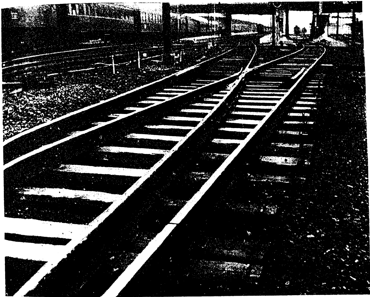
Fig. 7.ª — La SNCF viene zunchando desde el año 1941 todas las traviesas de madera; algunas se zuncharon in situ como las de esta fotografía.
