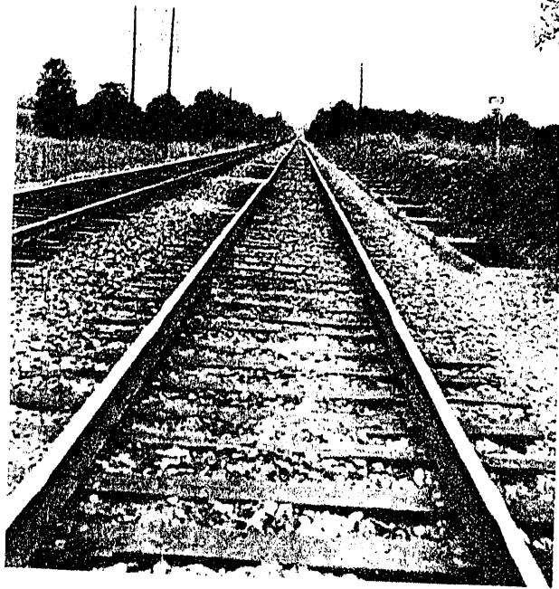
Fig. 1.ª — Barras largas (carril de 800 m.) sobre traviesas de madera.
