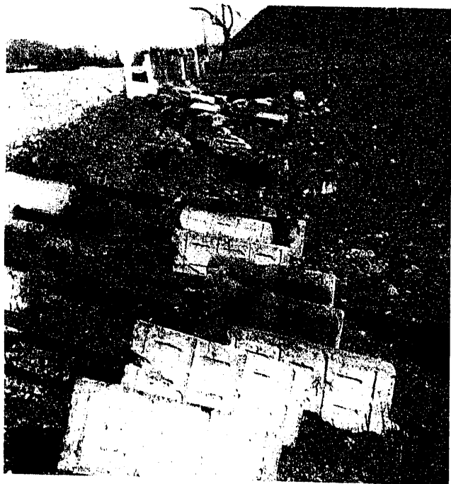
Fig. 8. a — Cómo quedan las traviesas R. S. después de un descarrilamiento: la foto de la izquierda corresponde a un descarrilamiento de RENFE, en Bribeña Burgos; la foto de la derecha es de un descarrilamiento más importante de la SNCF.
