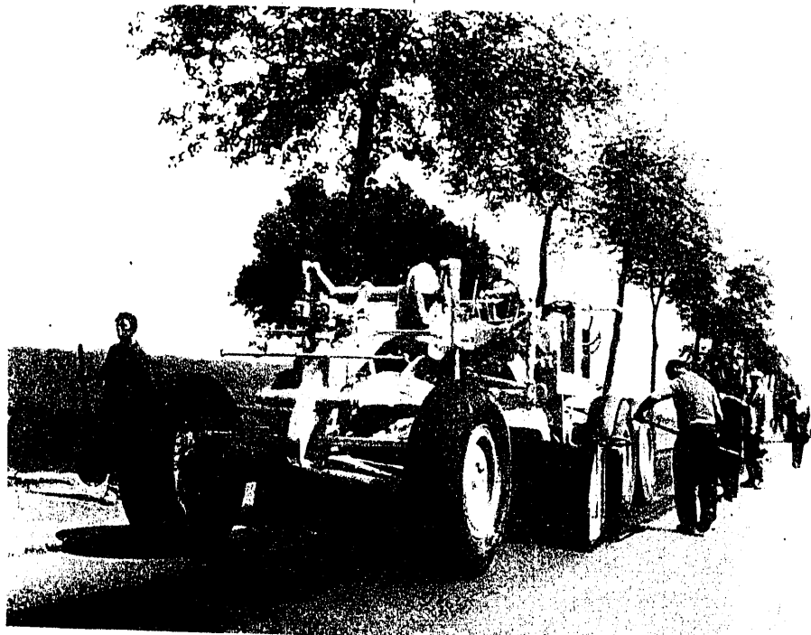
Fig. 1. a - Motoniveladora extendiendo aglomerado fino.
