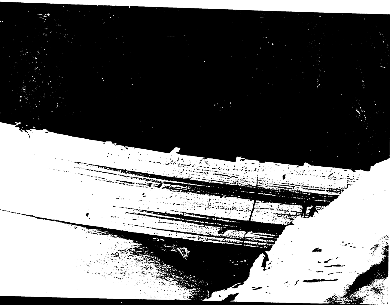
Foto 9. —Vista de la coronación de la presa, desde agua arriba, después del gran corrimiento.
