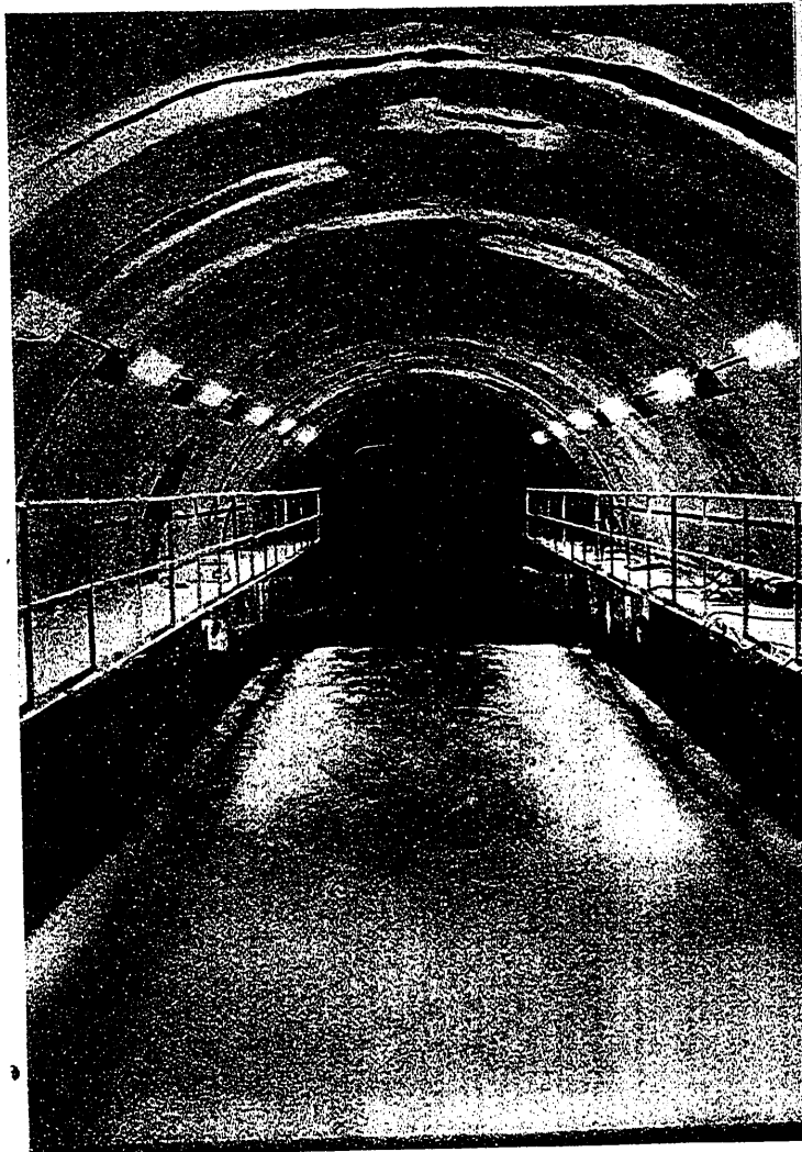
Fig. 11. — Cámara de Rotura de Carga vista desde aguas arriba.
