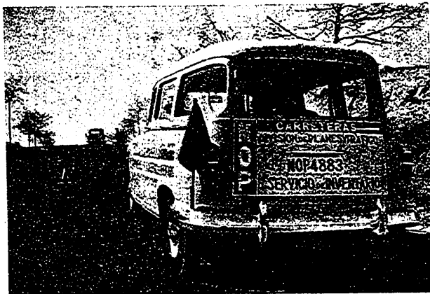
Fig. 15.—Equipo de inventario de características midiendo distancias de visibilidad. Obsérvese el faro blanco debajo del parachoques del coche delantero a punto de perderse en el cambio de rasante.
