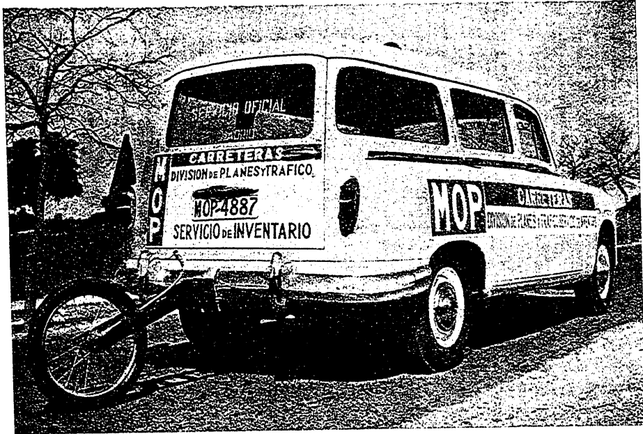
Fig. 1. a — Furgoneta de inventario con cuentakilómetros de alta precisión.
