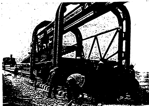
Colocación de parejas en avance (fase 1.ª).
