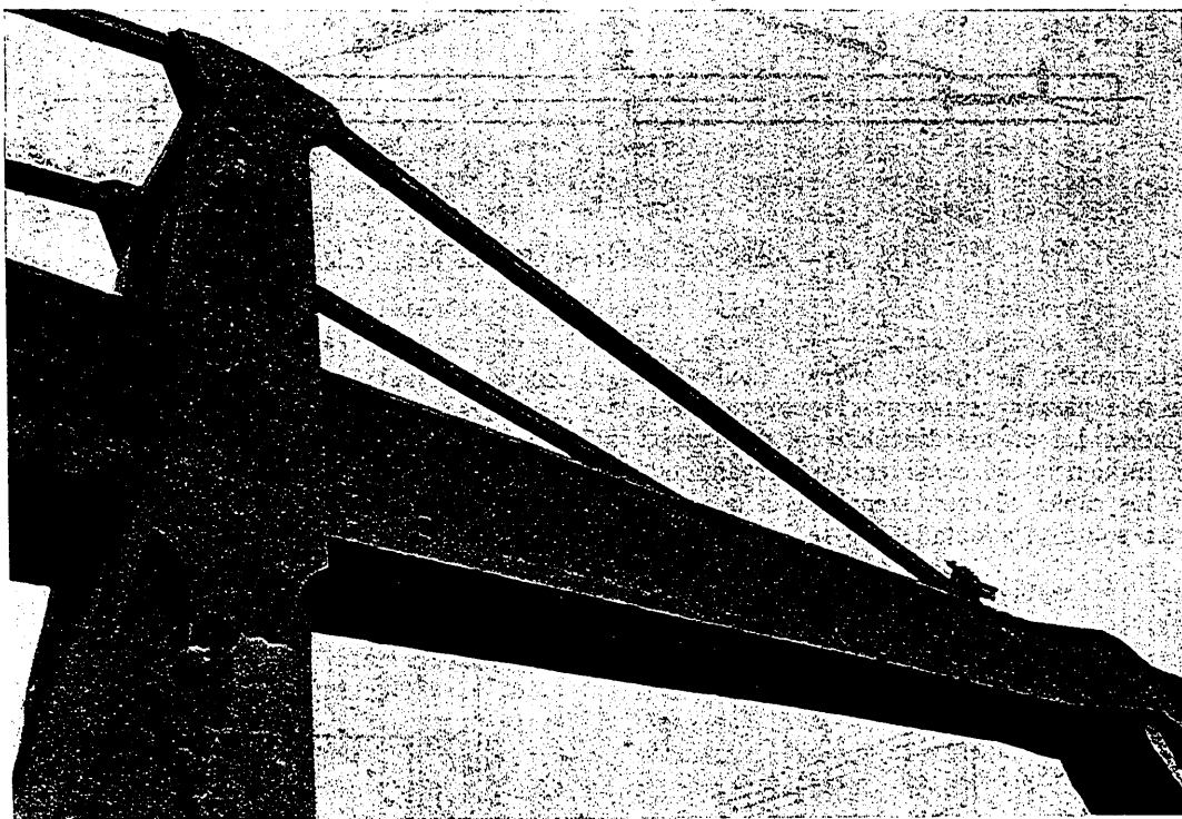
Fig. 4. a — Acueducto de Tempul, terminado. Vista parcial.
