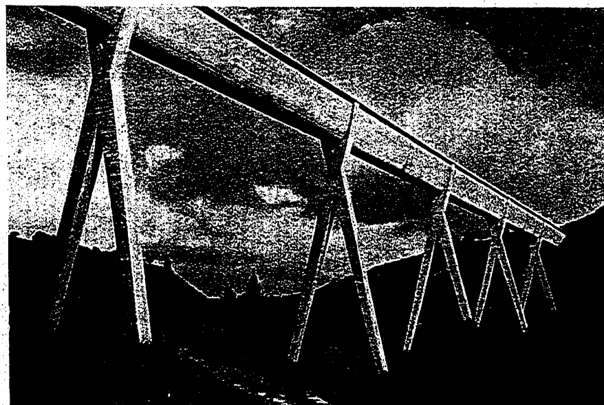
Fig. 21. — Acueducto de Alloz, terminado.
