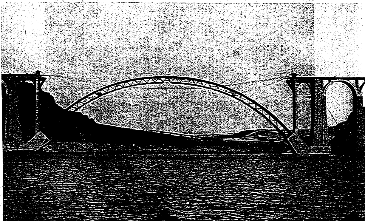
Fig. 17. — Cimbra del viaducto sobre el Esla.
