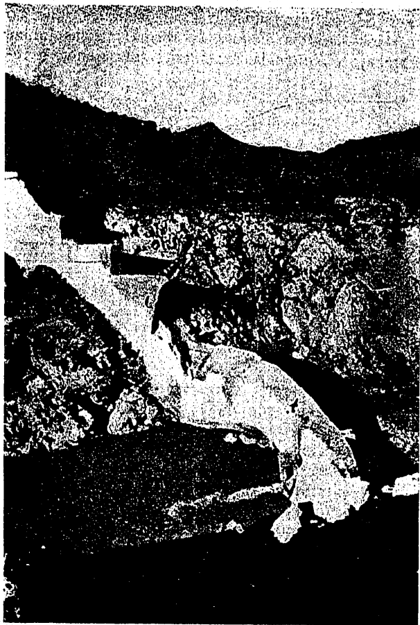
Fig. 12. — La gigantesca escalera de Malpasset, rota: c = juntas de contracción; t = juntas de trabajo.
