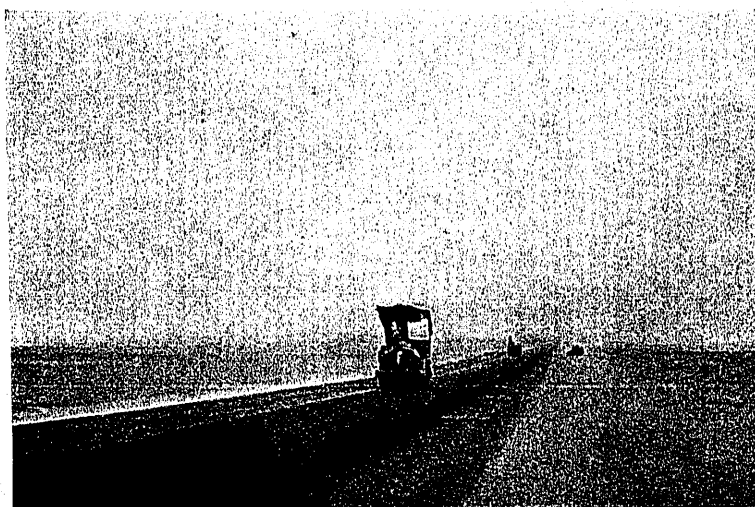
Carretera de Ouargla a Fort Lallemand, en construcción.
