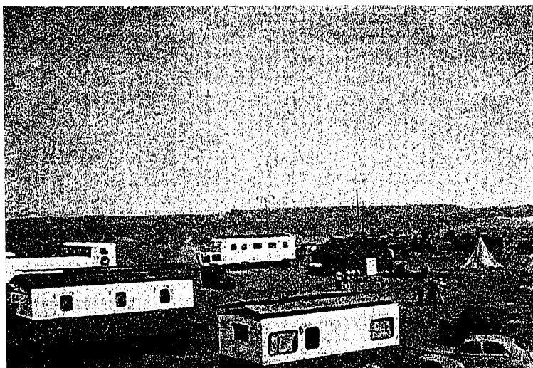
Laboratorio a pie de obra para estudio de los materiales para las carreteras. Instalación móvil en la obra de la carretera de Abdala a Tindouf.
