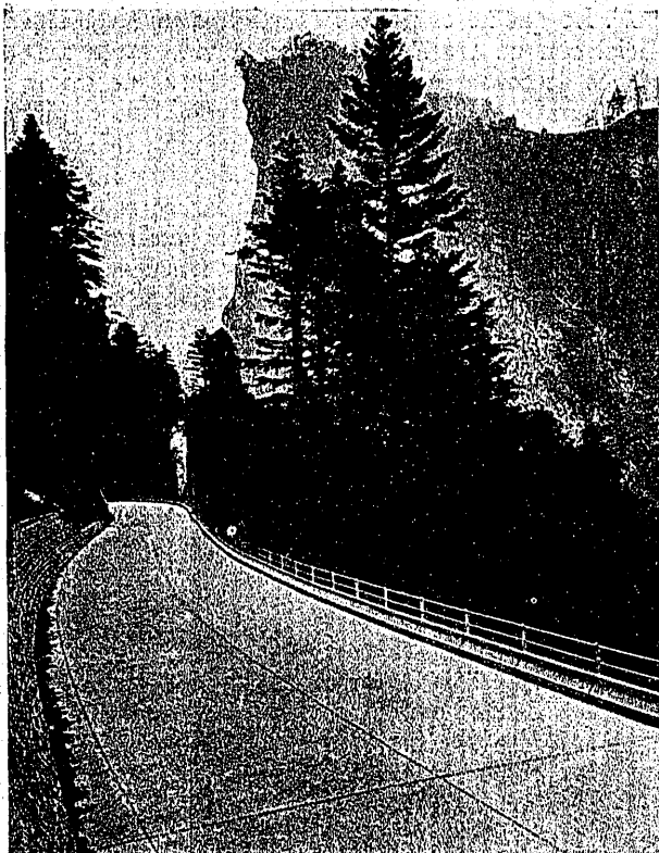
Fig. 2. a —En esta carretera de montaña San Bernardo (Suiza), la sección transversal no tiene paseos, escasamente pueden cruzar dos grandes camiones; la velocidad específica es reducida por lo escaso de la visibilidad; pero existe una defensa excelente de la parte de terraplenes y un magnífico firme de hormigón.
