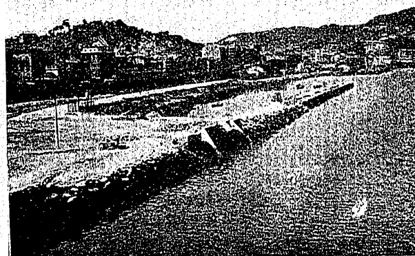
Fig. 30. — Escollera junto a la desembocadura del río Molino y comienzo de la primera alineación.
