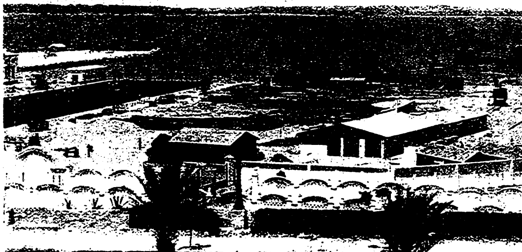
La dársena del dique seco, sin muelles ni abrigos, al iniciarse su ordenación. A la izquierda, el cuenco y la puerta del dique.
