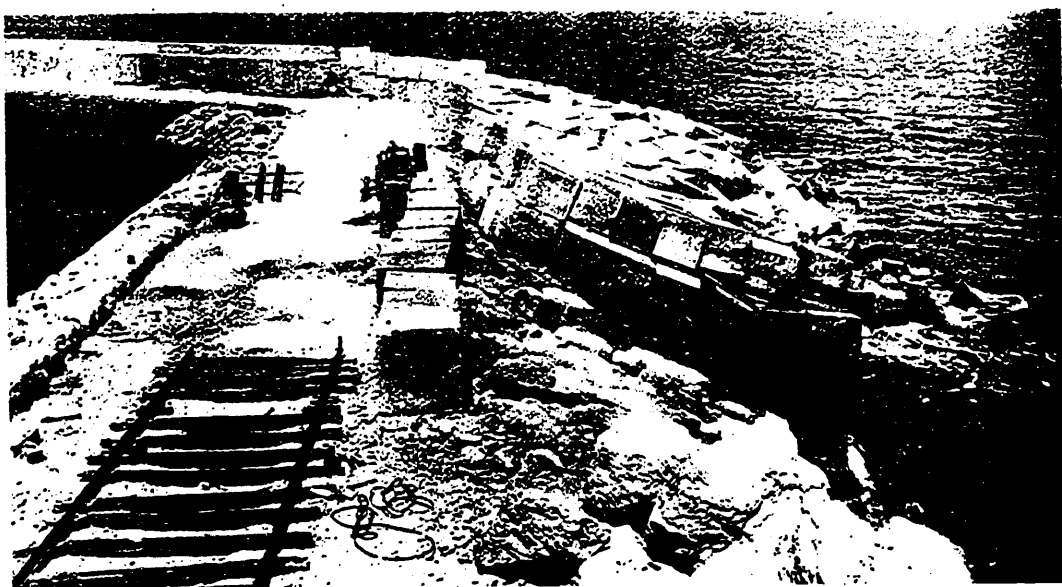
Detalle del manto principal de bloques de hormigón.
