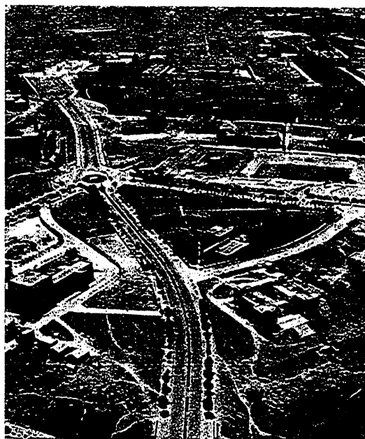
Fig. 4. a — Vista aérea del acceso de la carretera de La Coruña, por la Ciudad Universitaria.
