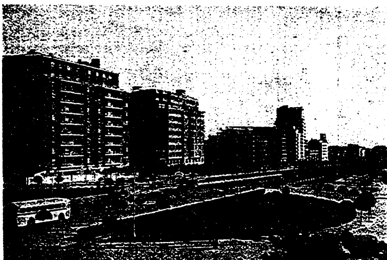
Fig. 10. — Modernos edificios en la avenida del Generalísimo.
