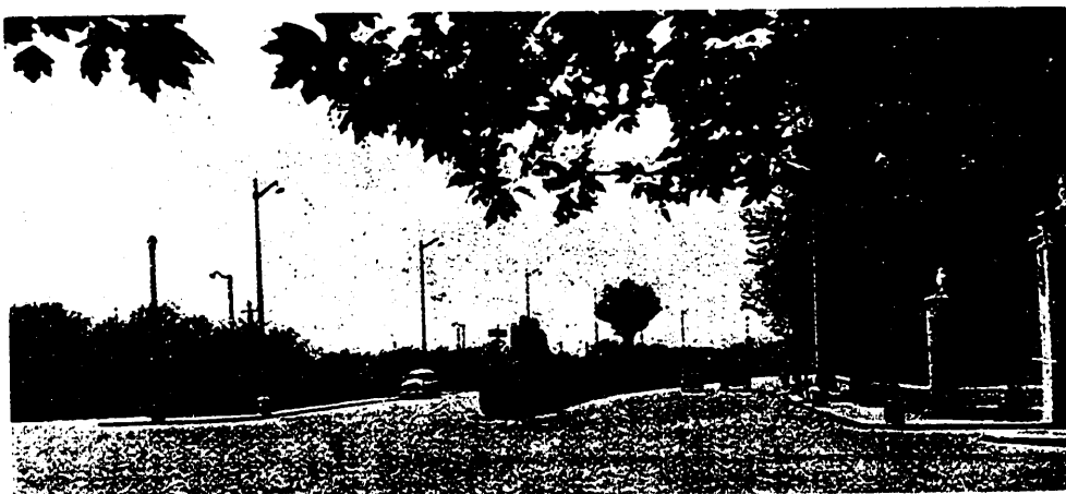
Fig. 22. — Arranque, junto al Puente del Rey, de la doble calzada en la carretera de Extremadura.
