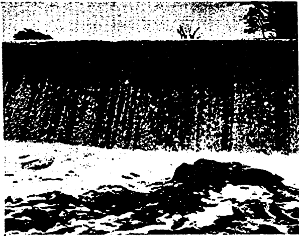
Fig. 2. a — Fotos del vertedero Werribee. Alturas de la lámina vertiente sobre la cresta: 0,18 y 0,24 m., respectivamente.
