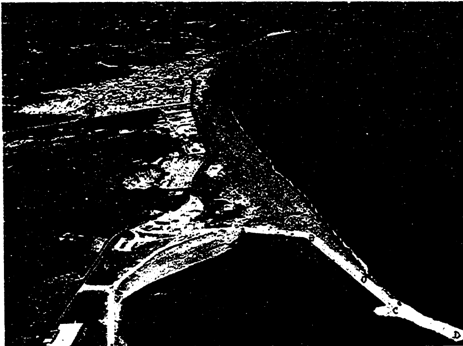
Foto 2.ª -- Estepona: Tercera alineación del dique de Levante, en construcción. Posición de la playa después de un fuerte temporal de Levante.
