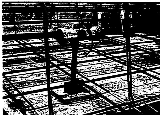
Fig. 1.ª — Aparato de medida de deformaciones, que quedará embebido en el hormigón.
