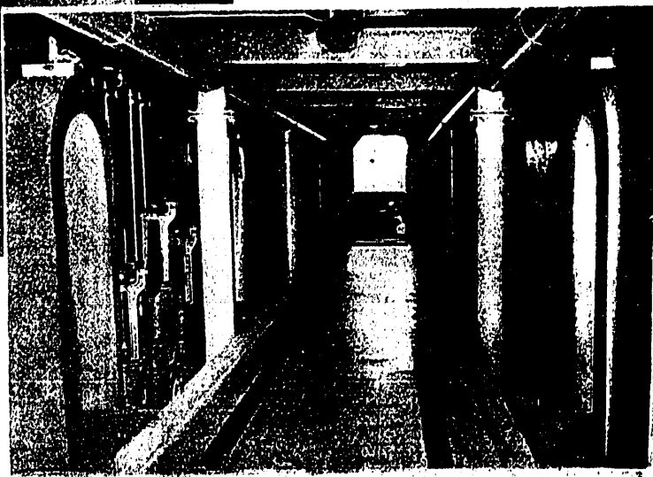
Fig. 10. — Estación del Eufrates. — Galería inferior de la batería de filtros.
