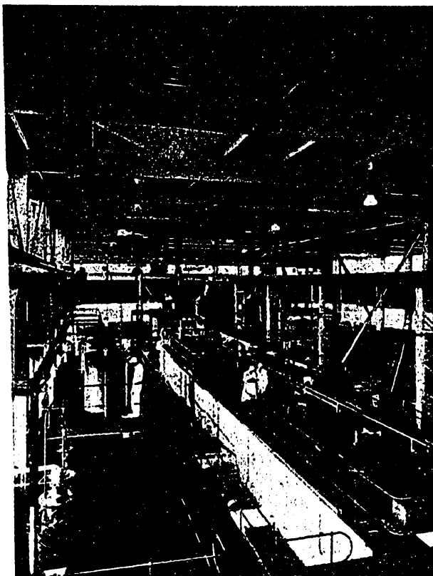
Interior de la anterior instalación.
