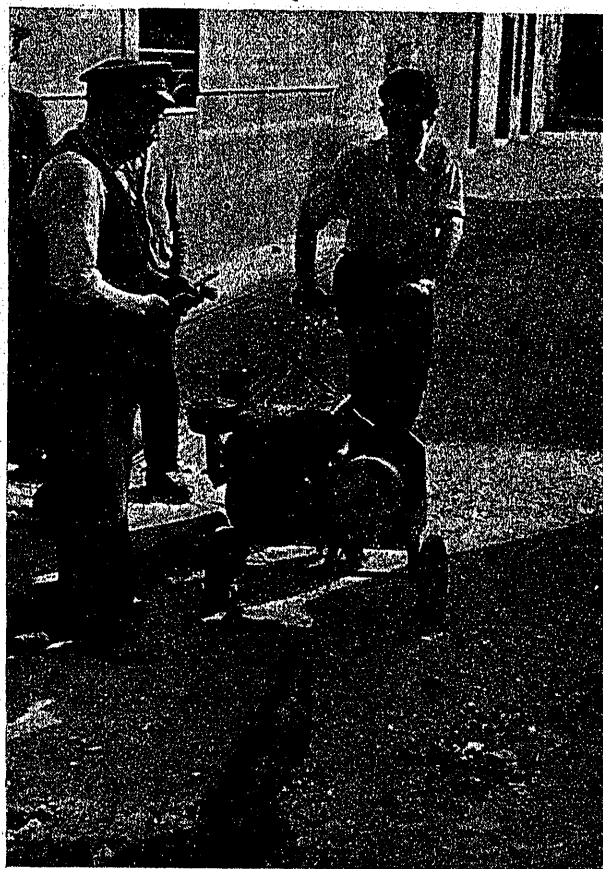
Fig. 4.ª — El motor llega a la cala. Se van a empalmar dos barras más.
