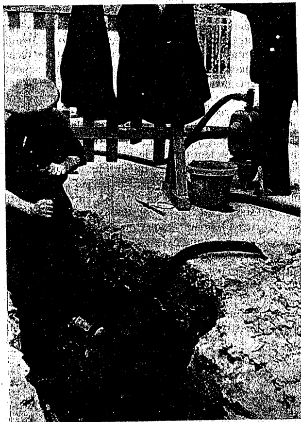
Fig. 7.ª — La bomba de agotamiento y el foso de aspiración.
