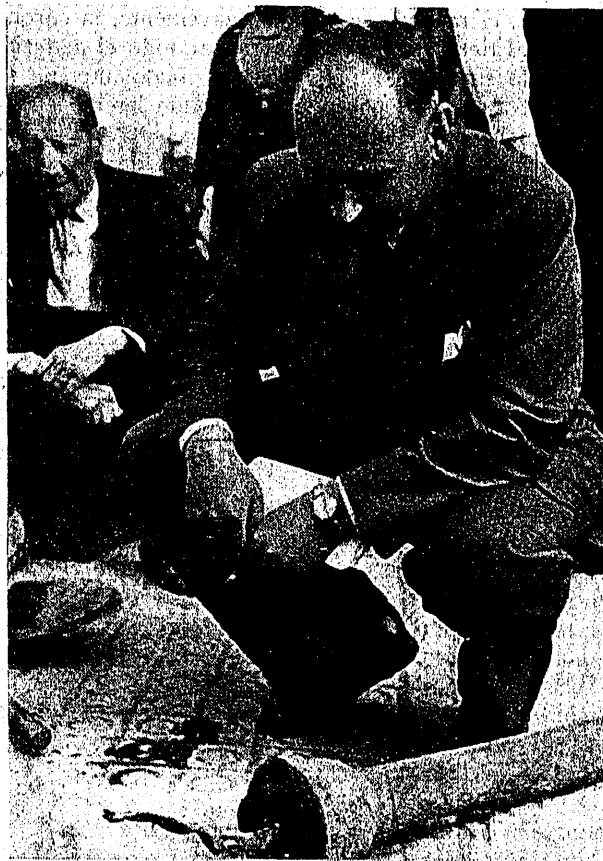
Fig. 9." — Uno de los fish del plomo de empalme de los tubos encontrados durante la prueba. Estos elementos son desmenuzados y arrastrados con el resto de los materiales.
