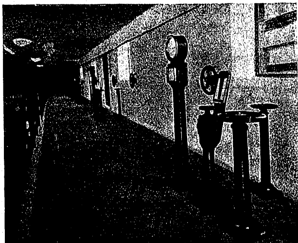
Foto núm. 8. — Witney. Mandos de los filtros.
