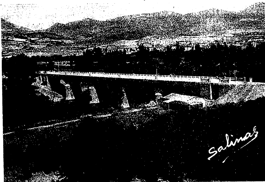
El puente terminado.
