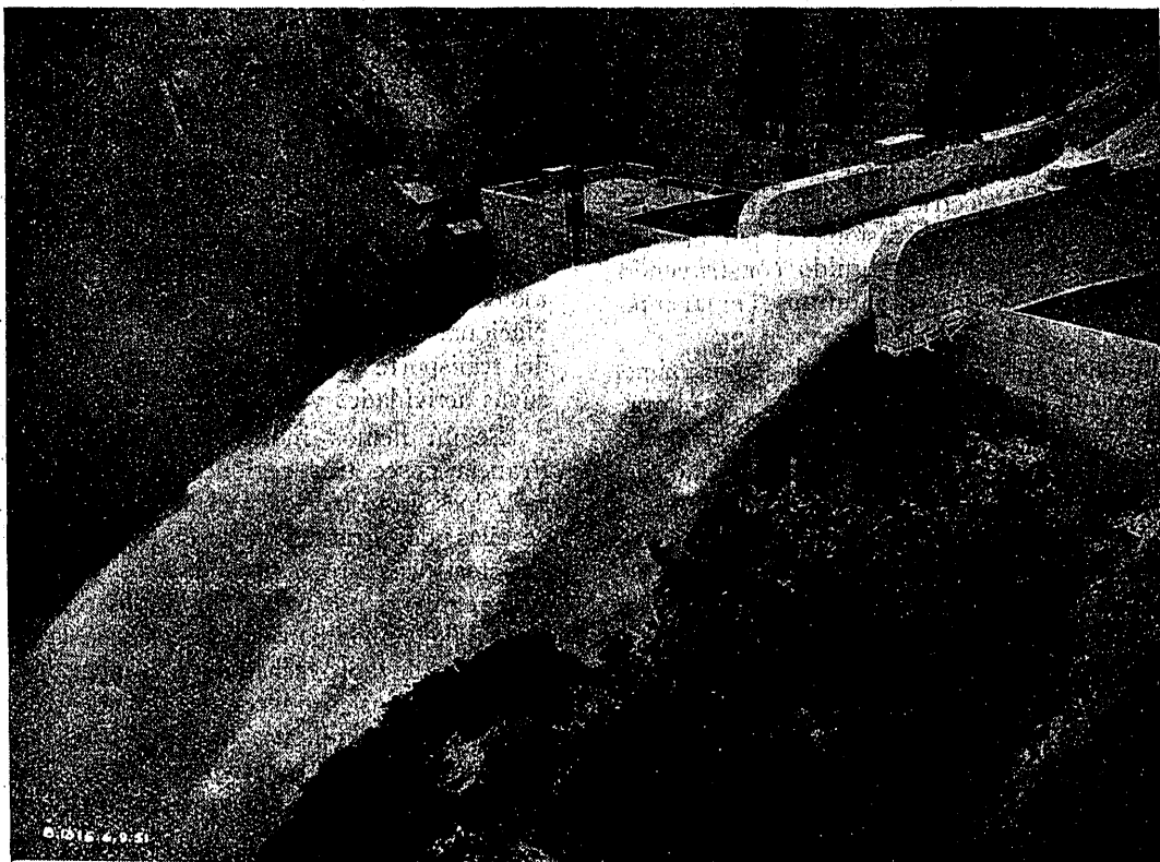
Presa de Bort-les-Orgues. Aliviadero de superficie. (Fot. Entreprises Métropolitaines.)
