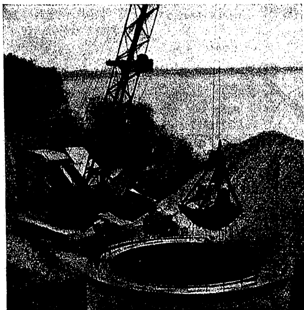
Fig. 2.ª — Construcción de un pozo.
