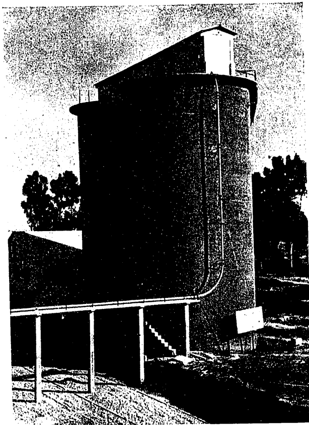
Silos de cemento y tubería de llenado.
