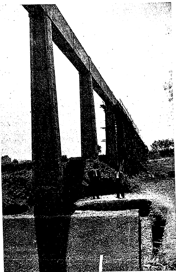
Canales del Guadalquivir (Cádiz). Acueducto de la Canaleja (González Quijano).
