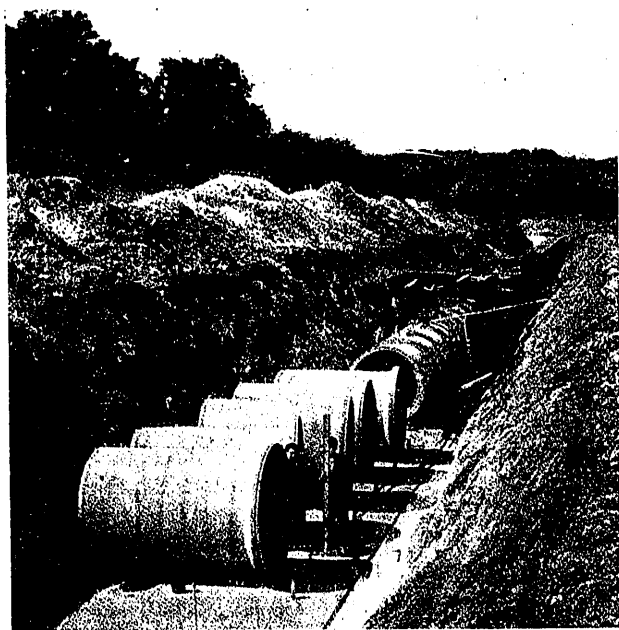
Fig. 10. — Colocación de colector tubular de 145 cm., en trinchera.
