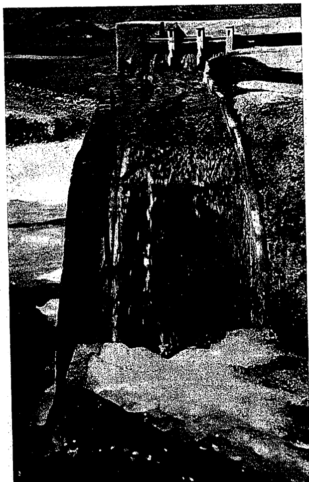
Fig. 11. — Vista del canal de descarga desaguando una avenida de 1400 m. 3 /seg., sin presa de retención.
