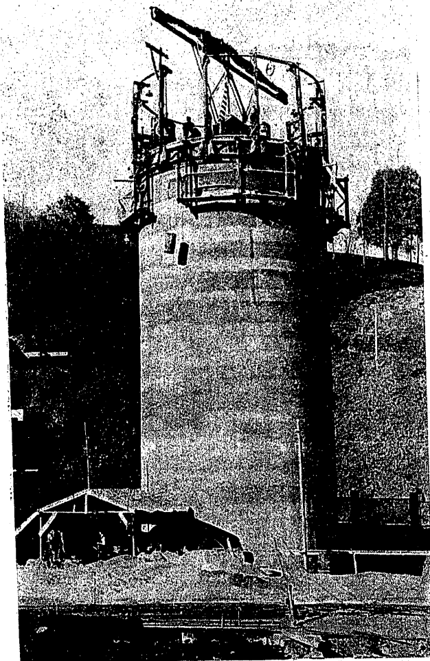
Fig. 9.ª — El silo en construcción de Cementos A. B. C., con la grúa elevando el hormigón.
