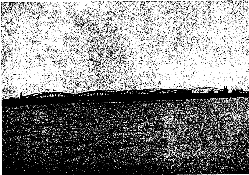
Fig. 4. a — Los puentes sobre el río Elba.
