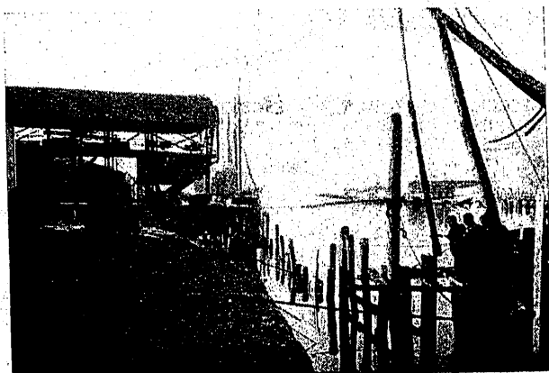
Fig. 6.ª — Construcción del tablestacado provisional de madera.
