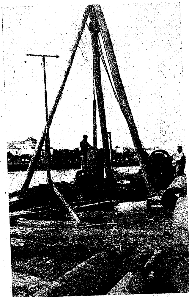
Fig. 9.ª — Ejecución de un pilote.
