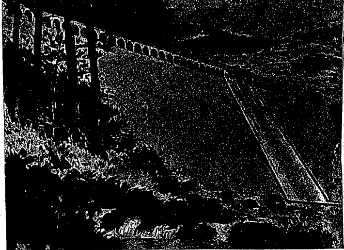
Fig. 5. a — Embalse de El Escorial (en construcción).
