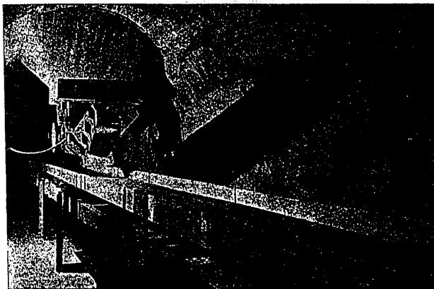
Galería y cinta longitudinal bajo el parque.
