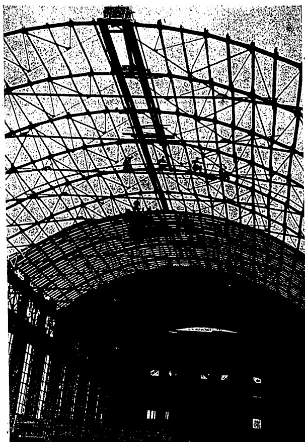
La bóveda de turbos durante su construcción.
