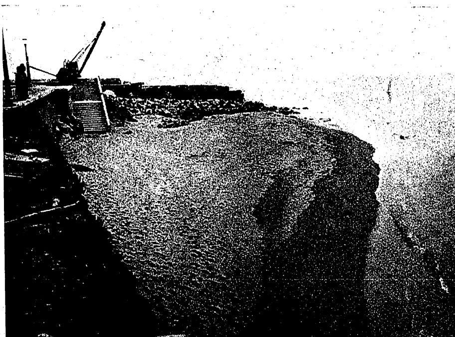
Foto. núm. 3.—Empezada la obra, se produce una playa aun inestable.
