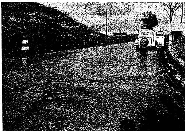
Fig. 2.ª — Carretera Nacional de Madrid a Francia por Barcelona. Tramo 454,888 al 464,365. Hm. 455,100.
