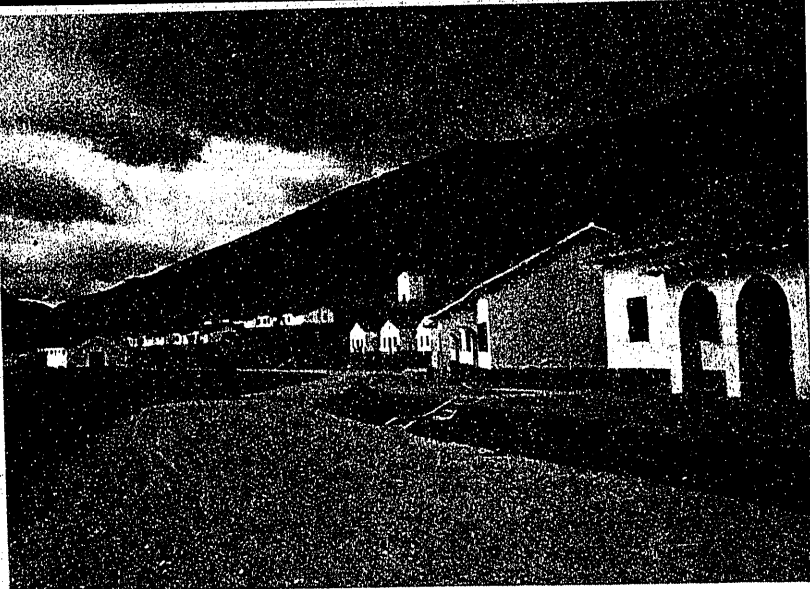
Fig. 2. a —La carretera desviada de Carrascosa a Sacedón, y los edificios auxiliares. Al fondo, la cerrada.
