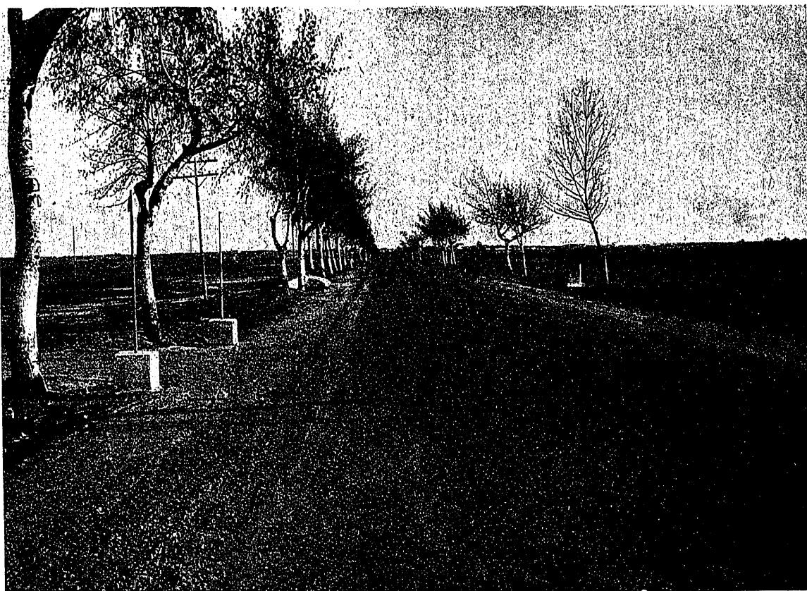
Aplicación de betún fluidificado. C. N. Madrid-Coruña, Km. 20.
