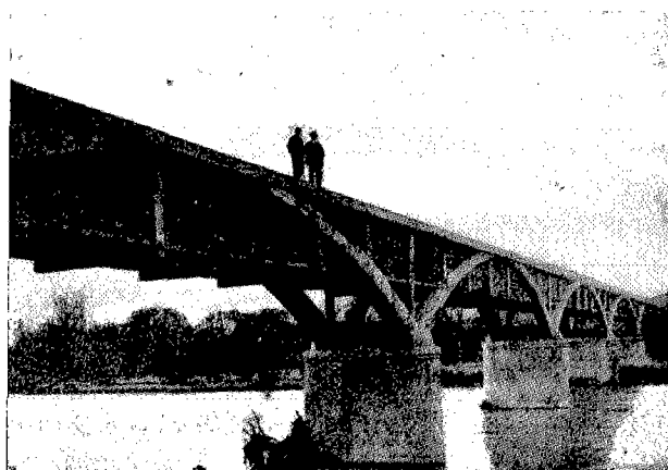
Fig. 7. a . — Acueducto Pugliese, sobre el Ofanto (Italia).
