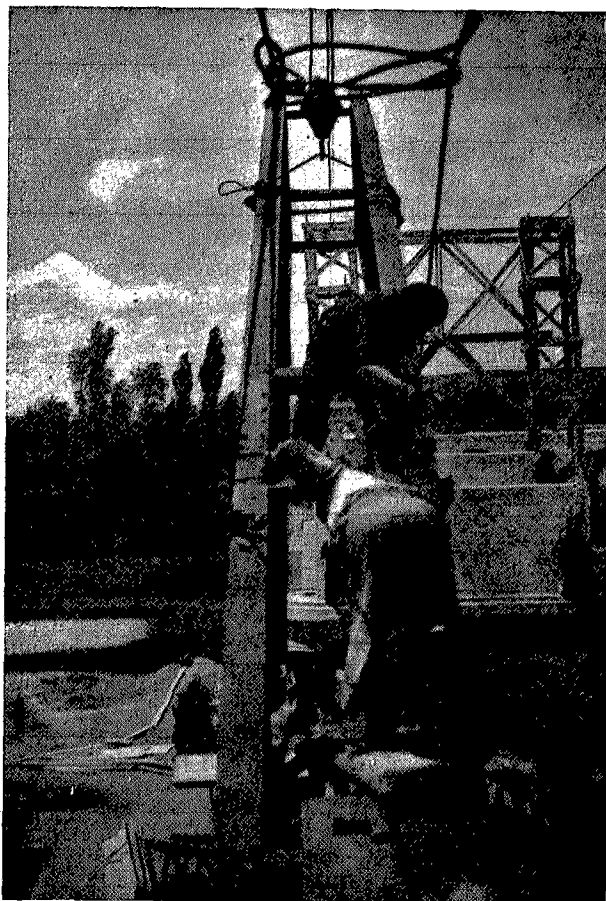
Fig. 14. — Montaje en obra, con pasadores, de las armaduras soldadas en taller.
